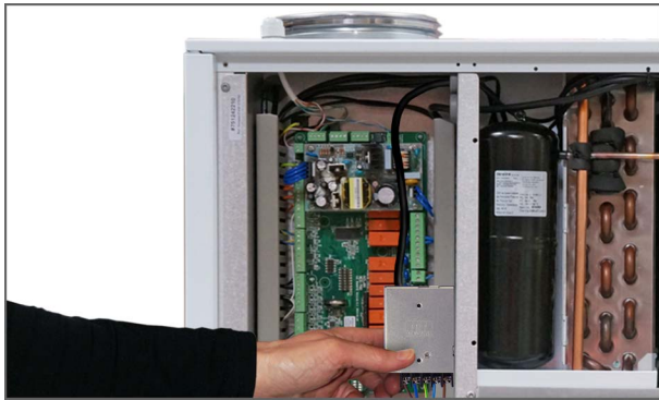
7. Installez la boîte d'alimentation dans le caisson pour l'électronique de la centrale (prépercez 2 trous pour les deux vis fournies)
