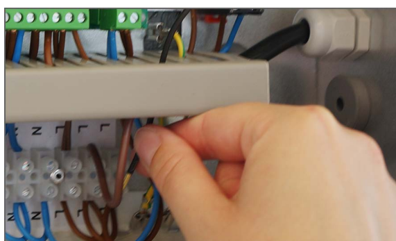
5. Raccordez les câbles comme indiqué sur le schéma électrique.
