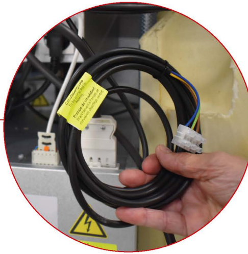
Câble d'alimentation pour la pompe de circulation du circuit de chauffage
