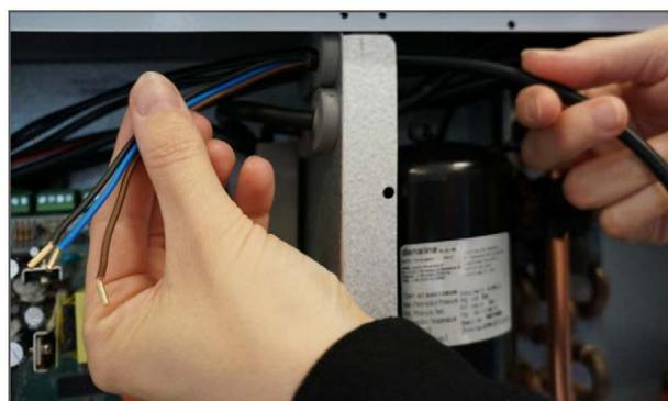
6. Faites passer le câble du capteur de CO<sub>2</sub> au travers de la conduite de câble jusqu'à la carte électronique. Puis, raccordez le câblage au boîtier d'alimentation.
