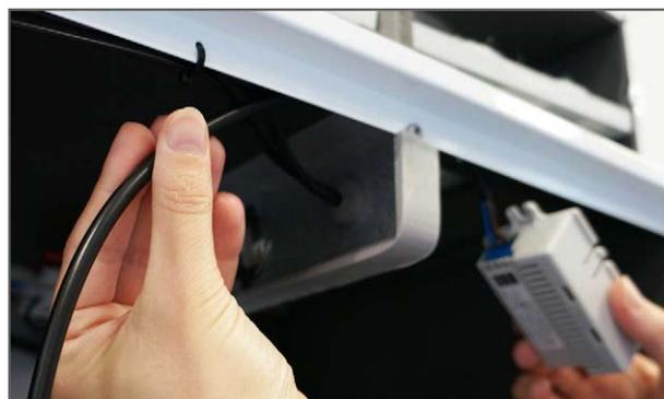
4. Passez le câble du capteur de CO<sub>2</sub> à travers ce trou.
