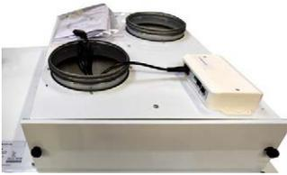
Concernant les centrales Compact P (AIR/GEO), le gateway (passerelle) est installé sur le dessus de la centrale sur le boîtier de filtration.
