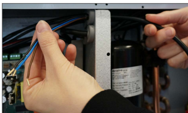
6. Faites passer le câble du capteur de CO 2 au travers de la conduite de câble jusqu'à la carte électronique. Puis, raccordez le câblage au boîtier d'alimentation.
