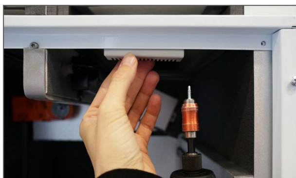
5. Installez le capteur CO 2 dans le couvercle supérieur avec des vis auto-perçantes (incluses dans le kit de capteur CO 2 ).
