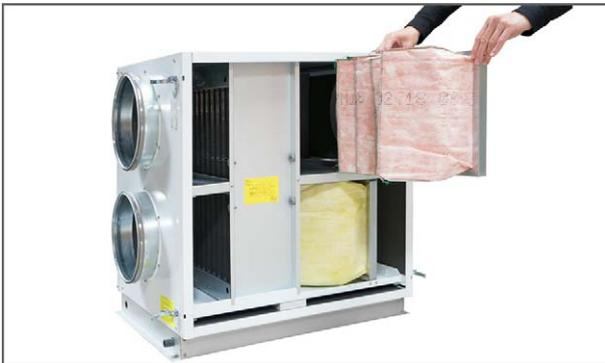
3. Les 2 filtres situés à droite sont retirés de l'appareil.
