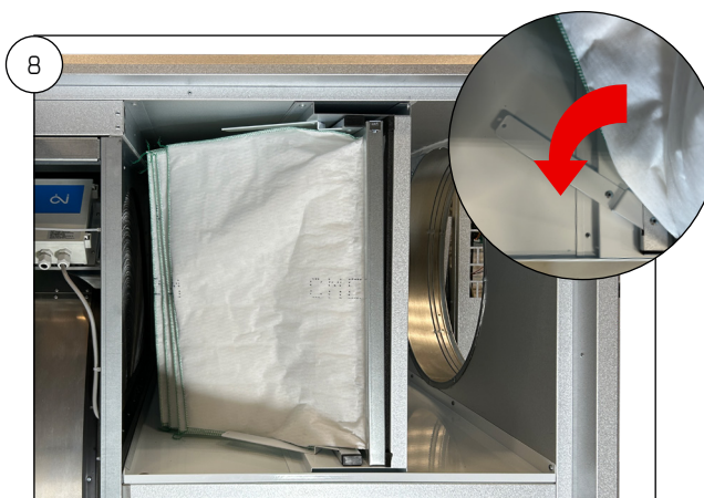
Fixer les filtres en ramenant les poignées rotatives vers l'avant afin de garantir des performances optimales et une bonne qualité d'air.
