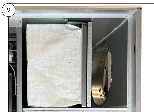
Le remplacement des filtres est maintenant terminé.
