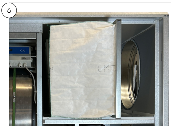
Insérer les nouveaux filtres dans le cadre du filtre.
