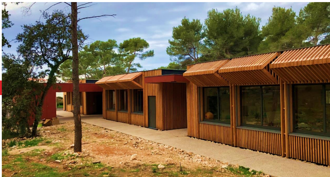
École élémentaire Bouc-Bel-Air (13), équipée de la solution NILAN VPL28 & FU28 assurant l'autonomie de ventilation, chauffage, température et une excellente QAI
