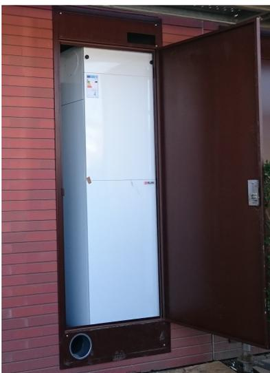
Chaque logement est équipé d'une centrale multifonction 4 en 1, de type COMPACT S. Ce combiné thermique assure la ventilation double-flux, le chauffage, et la production d'eau chaude sanitaire. En été, les cycles de production d'eau chaude permettent le rafraîchissement gratuit des logements.
